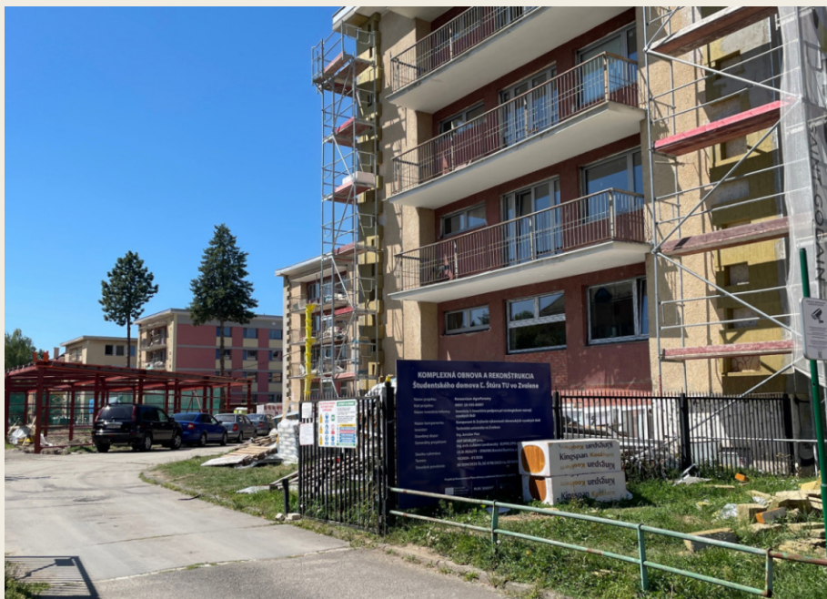
Pohľad na areál Študentského domova Ľudovíta Štúra po začatí modernizácie
